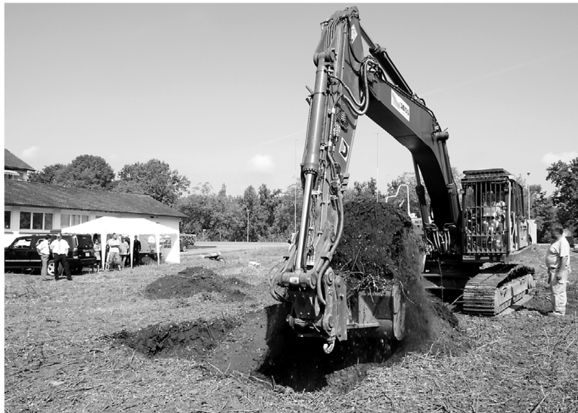
Den Spatenstich haben Röbi und Ruth Stocker mit dem Bagger vollzogen, jetzt kann der Neubau beginnen. Foto: Valentin Zumsteg
