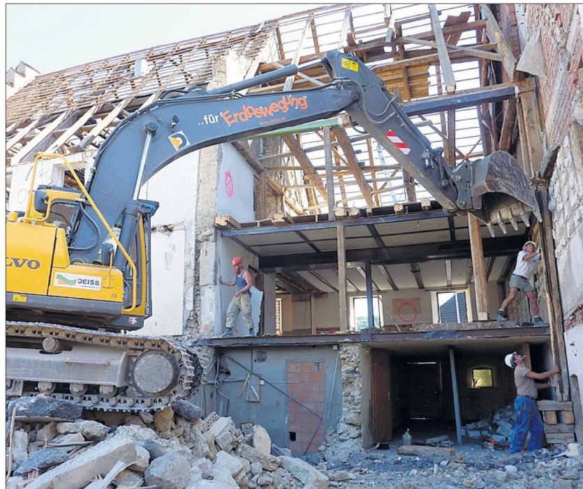
GEFÄHRLICH Bauarbeiten beim «Löwen» in Herznach. GHI
