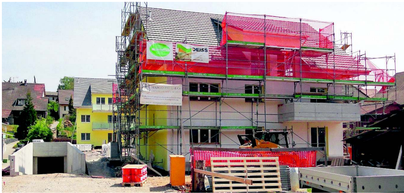
Modernes Wohnen auf einem alten Siedlungsplatz in der neuen Überbauung im Herznacher Unterdorf. CHR
