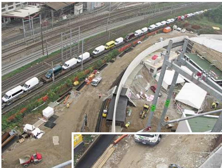
Die Ringmauer, die den Freizeit- und Geschäftskomplex vom benachbarten Gleiskörper abgrenzt, wird mit Aushub verfüllt.
