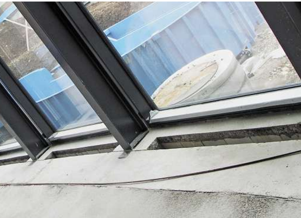
Damit die Glasfronten der Wasserwelt wegen des Wasserdampfes nicht ständig beschlagen sind, wurden am Boden Lüftungen eingebaut.
