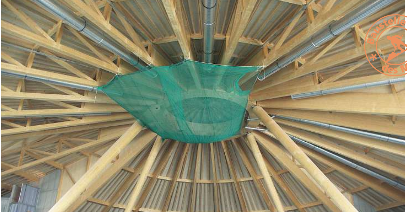
Aus Sicherheitsgründen wurde für die Dauer der Bauarbeiten unter dem Kuppeldach ein Netz gespannt.
