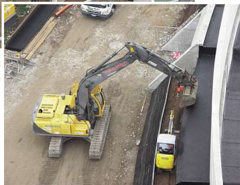
Die Ringmauer, die den Freizeit- und Geschäftskomplex vom benachbarten Gleiskörper abgrenzt, wird mit Aushub verfüllt.
